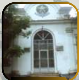
1914 Posto de Assistência da Vila Militar
